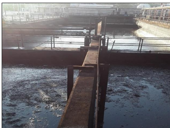
ภาพที่ 2.2-11 API Separator ที่สถานีผลิตลานกระบือ
